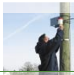
Installation des tubes à St Illiers-la-Ville
