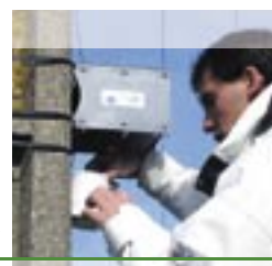
Pose des tubes à Bréval
